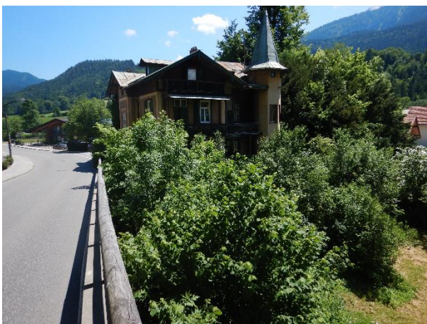
Abbildung 1 östliche Ansicht Bestands Bebauung
